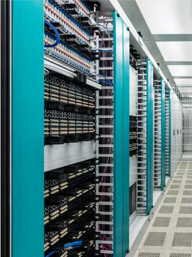
Sonderanfertigung für das Colocation RZ mit Zutrittsbeschränkungen bzw. Zonierungen durch Abtrennungen.
