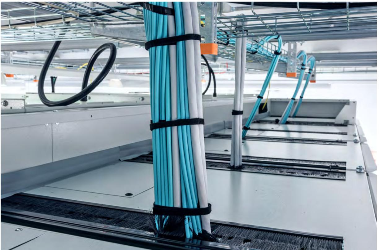
dtm Kaltgangeinhausung Sonderanfertigung im Bestand mit speziellem Doppelboden und Metallwandkonstruktion
